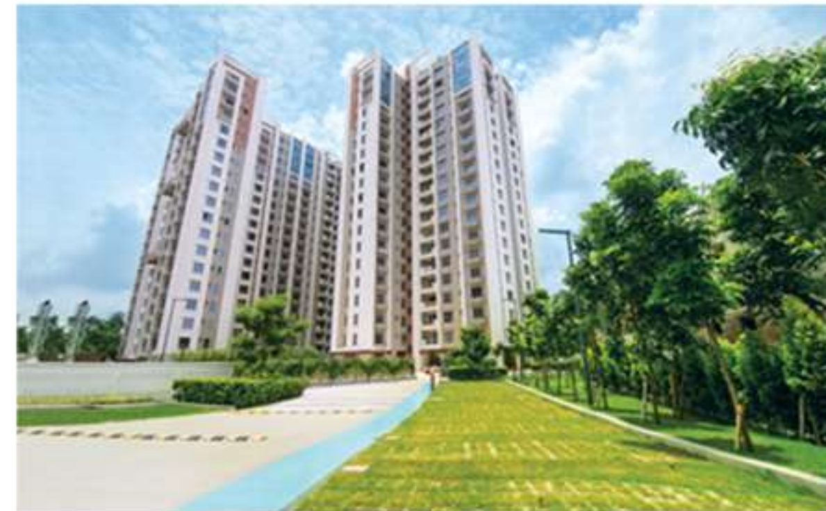
Ozone South EM Bypass
